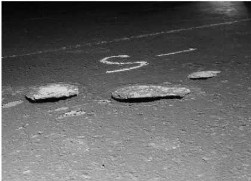
Figura 6.30 – Fundo de tanque de diesel
