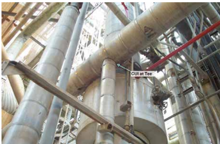
Figura 6.5 – "T" em uma linha de etileno com 1.000 psig de pressão antes da remoção do isolamento
