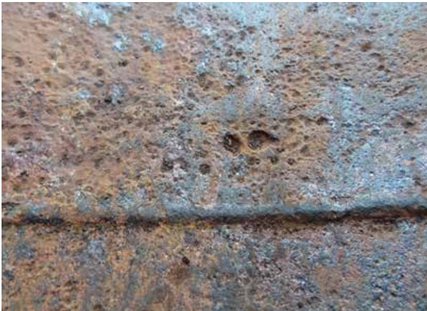
Figura 6.34 – Boca de visita de separador eletrostático
